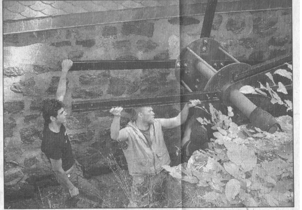
Vier U-Profile halten das Rad später an der rotierenden Achse.
