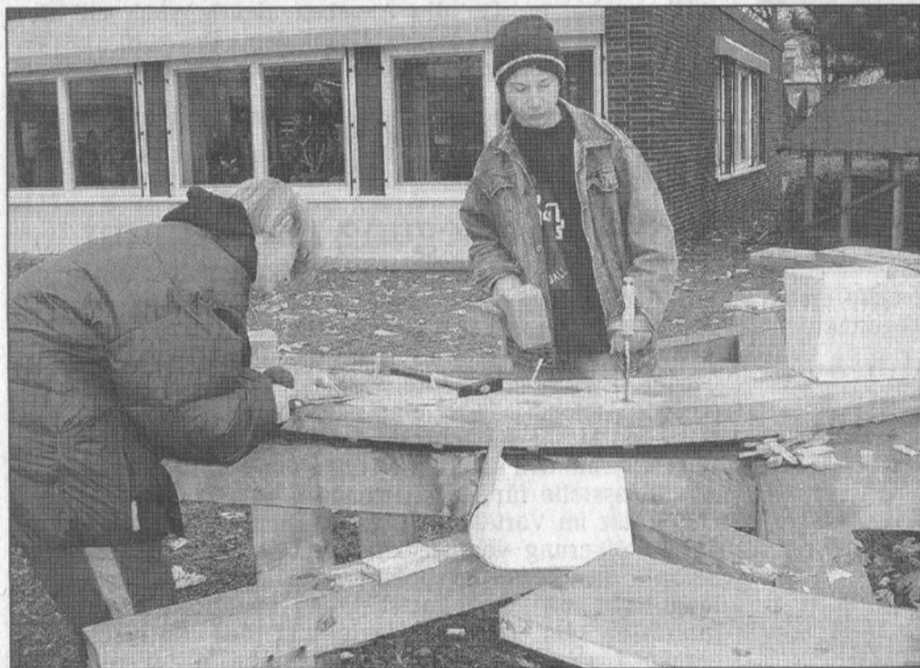
Fertigung der 24 Holzsegmente an den Gewerblichen Schulen in Dillenburg.
